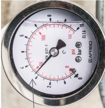
Druck am Einlauf in die Osmosefilter gute 3 BAR
