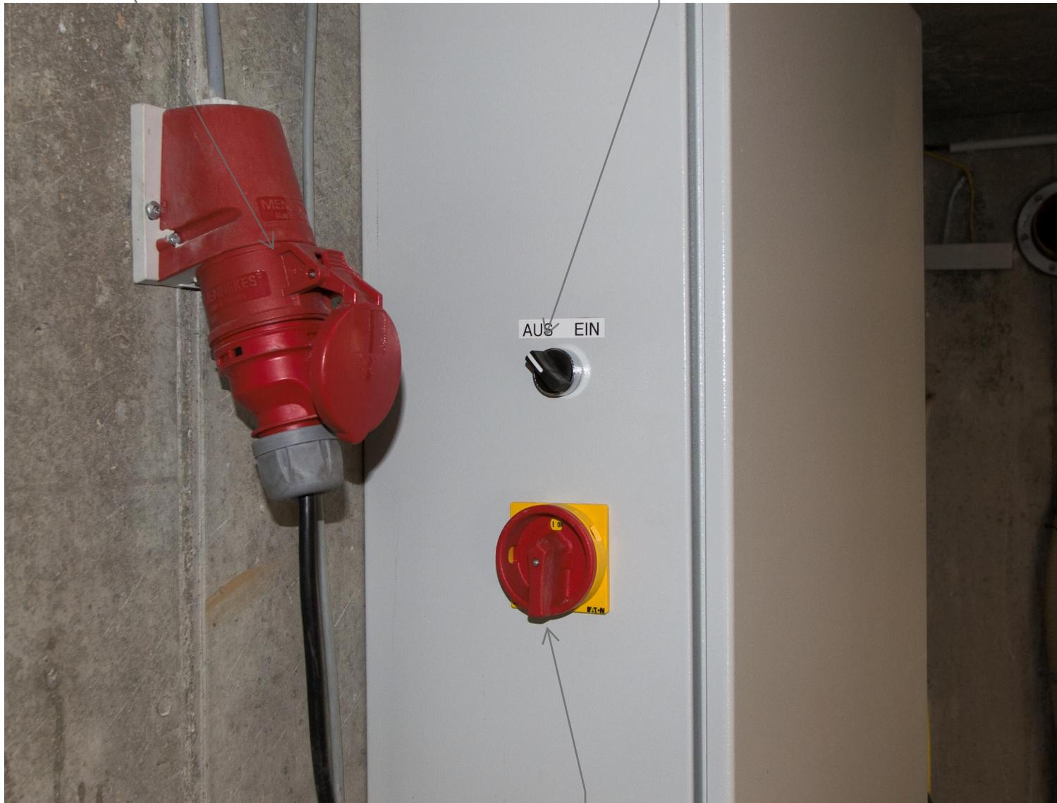
"Not Aus" Hier wird die Anlage stromlos geschaltet. Das hat zur Konsequenz dass im Winter ein Einfrieren der Düsen und daraus resultierende schwerwiegende Schäden nicht auszuschließen sind.
