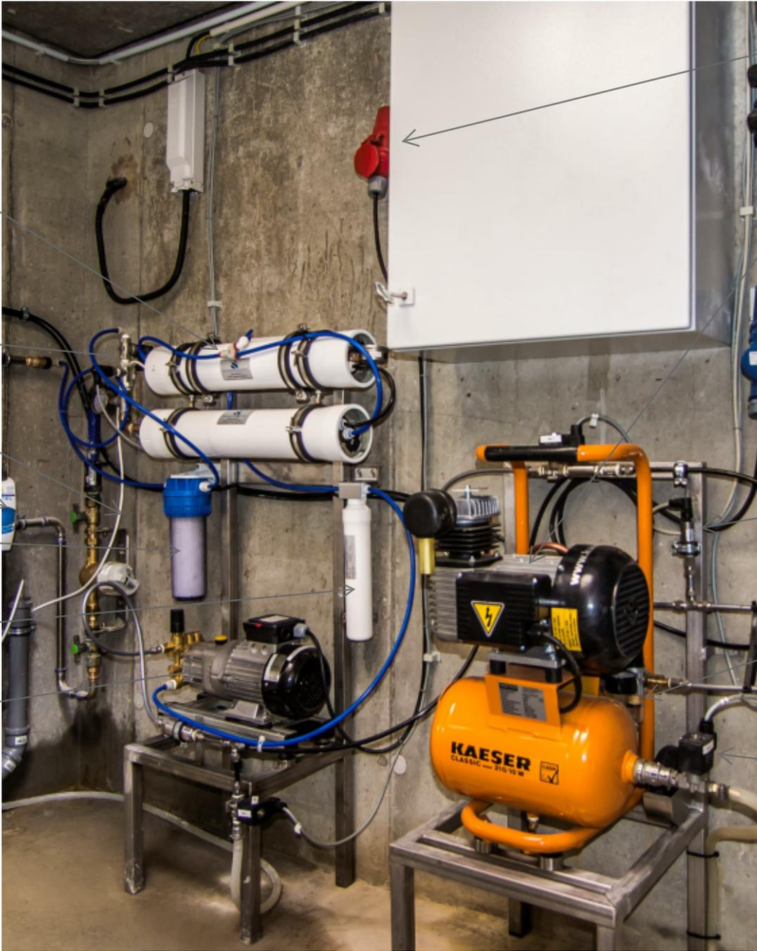
Osmoseanlage von Greifenstein Wasserveredlung [www.greifenstein-wasser.de](http://www.greifenstein-wasser.de) Diese funktioniert mit dem Leitungswasserdruck. Das Spülwasser fließt ins Abwasser. Die Cross-flow-Membran-Patronen müssen alle 2 Jahre mit Säure gereinigt werden.
